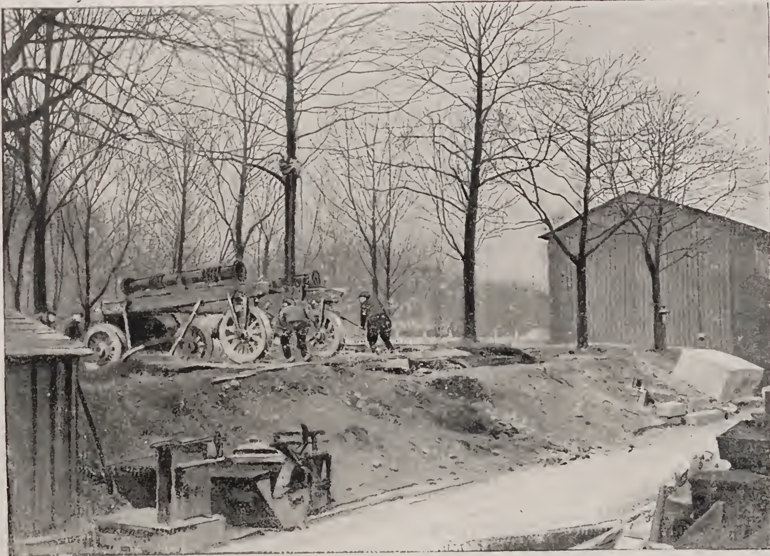
SUR LES CHANTIERS. — Relèvement des arbres sur les pentes en remblai du Cours-la-Reine accédant au Pont Alexandre.
